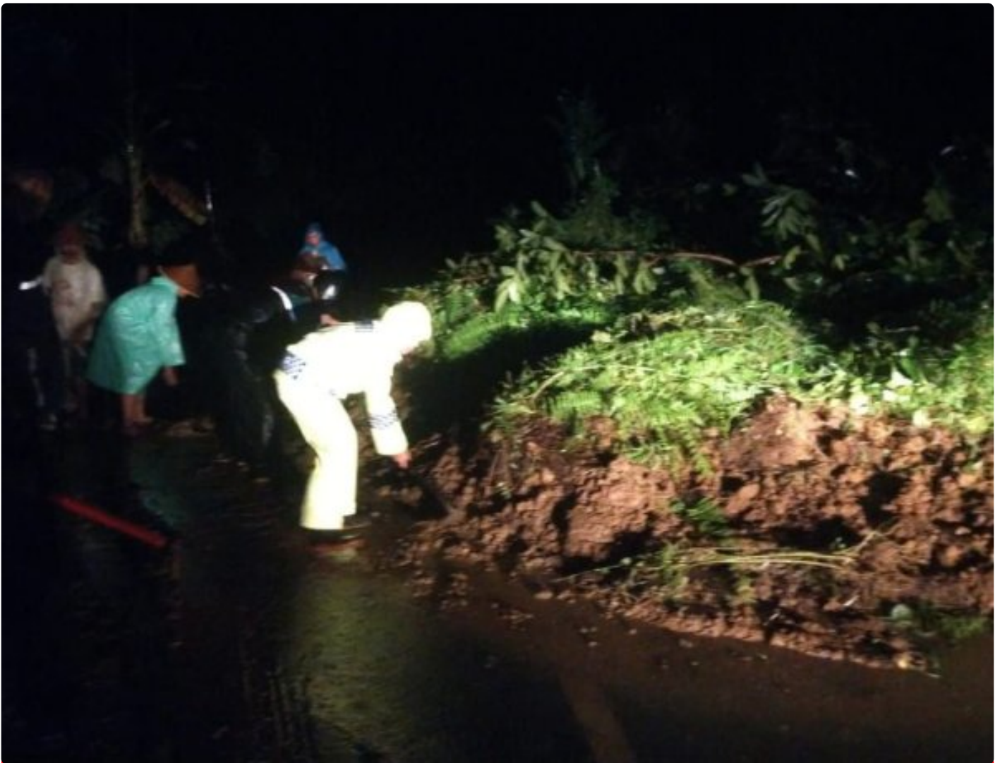
Tanah Longsor Tutup Akses Jalan di Blok Babakan Sari, Darma, Kuningan
